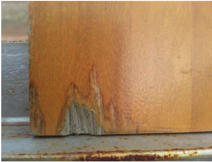
INFILTRAÇÃO POR BAIXO DA CAMADA DE VERNIZ APÓS 1,5 ANOS*
