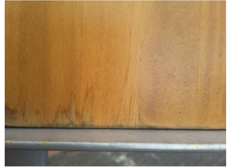
INFILTRAÇÃO POR BAIXO DA CAMADA DE VERNIZ APÓS 1 ANO*
